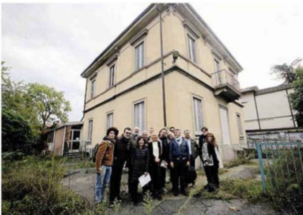
La palazzina di via Spallanzani durante una visita avvenuta lo scorso aprile. La palazzina, costruita all'inizio del Novecento per ricoverare i malati infettivi, successivamente riconvertita in una scuola per alunni disabili, diventata per alcuni decenni un centro di accoglienza per richiedenti asilo Foto Fabrizio Radaelli
